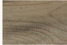
Milieukiemen, schimmelvlekken en lichte schimmel
